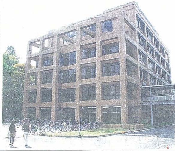
弁護士研修センター（仮称）が入居する岡山大の文化科学系総合研究棟Ⅱ岡山市北区津島中
